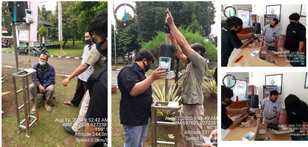
Gambar 83. Proses pemasangan AWS Telemetri Display
