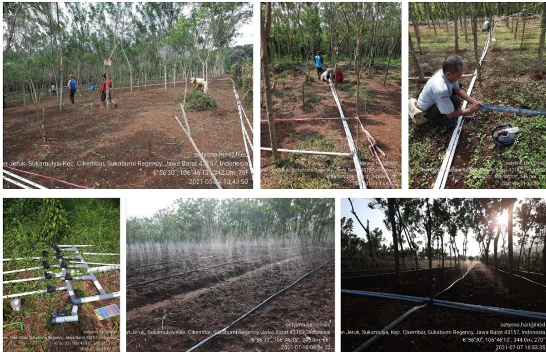
Gambar 28. Instalasi Jaringan (Atas) dan Pengujian (Bawah) Irigasi Tanaman Kedelai Dibawah Naungan
